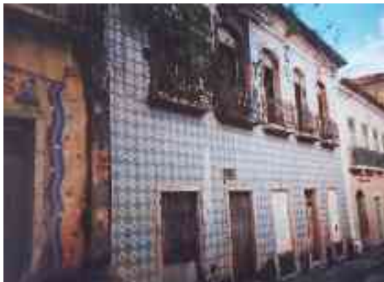
Maison coloniale en ruine avec azulejos
