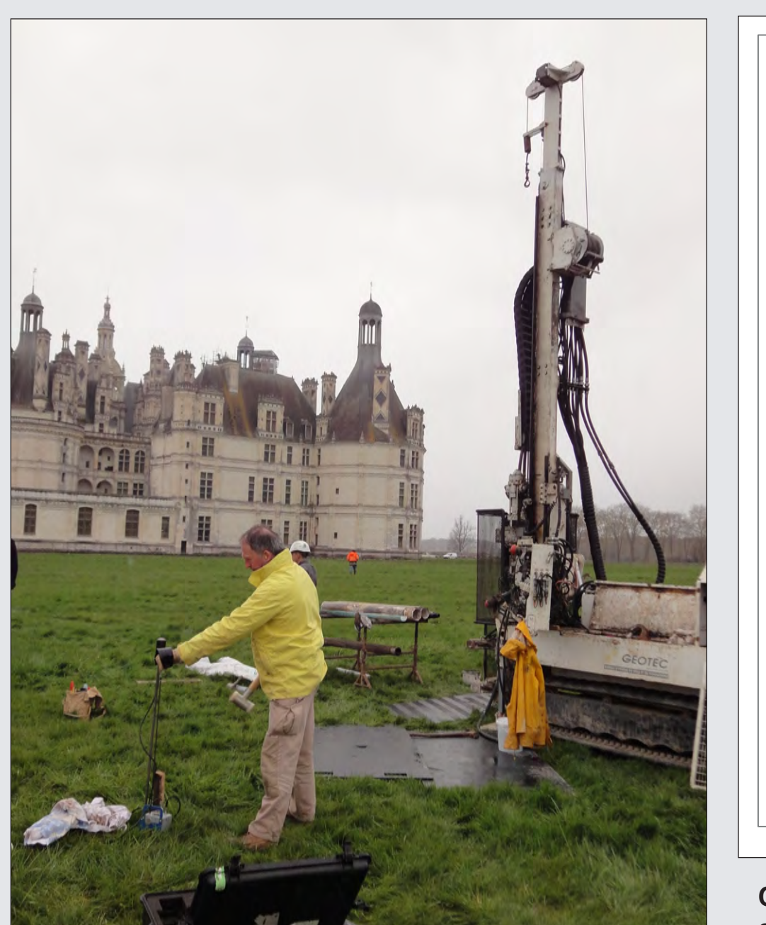
Sondages au PANDA® et carottier. A. L.-Dehecq, CD45
